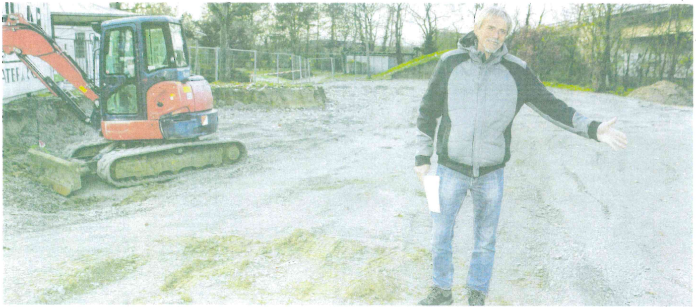
Noch sind nur die Dimensionen sichtbar: Matthias Degen zeigt auf der Baustelle des Skateparks, wo später welche Betonelemente auf der „Street“ die Skater für ihre Tricks erwarten werden.
